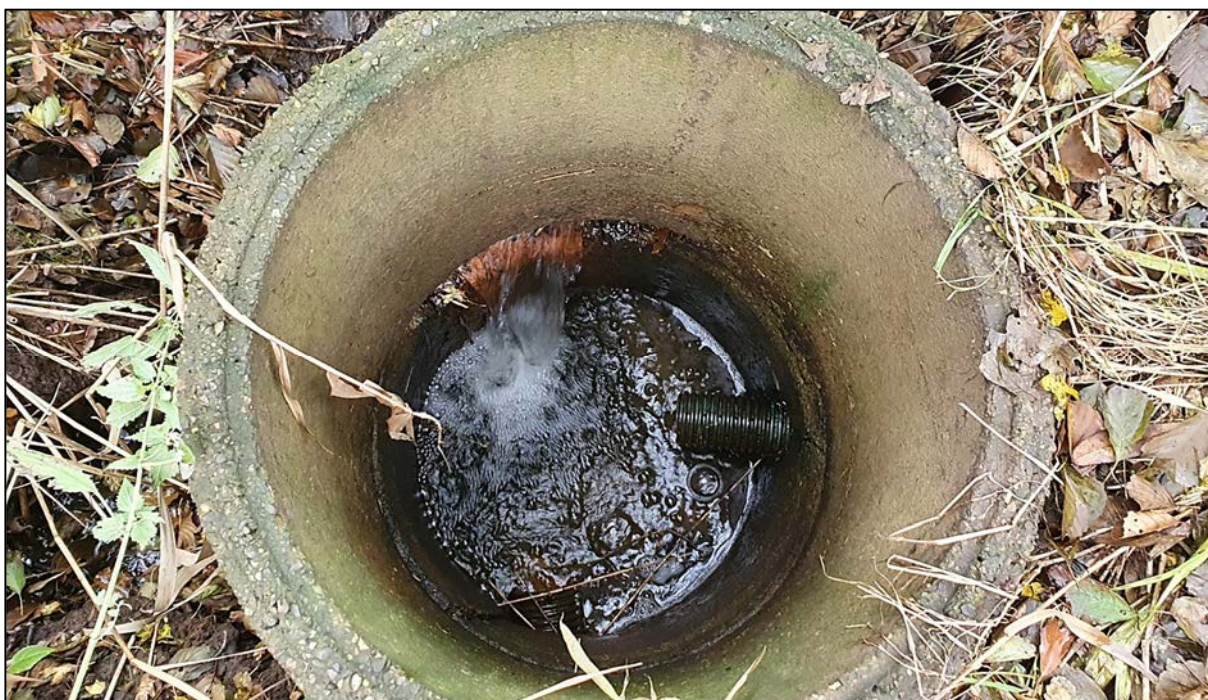
Figur 4-20 Brønden hvorfra der etableres et nyt fastrør, for at sikre overrisling med drænvand fra baglandet.
